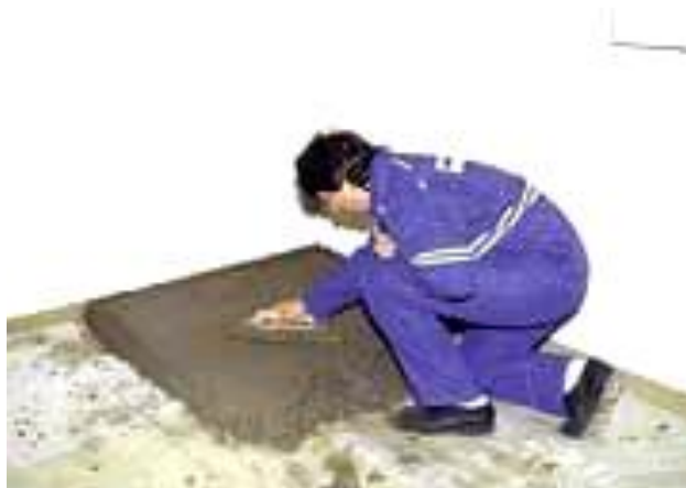
nanášanie betónového poteru
