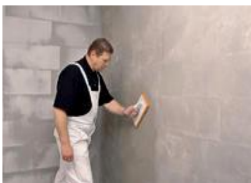
filcovanie penovým hladidlom
