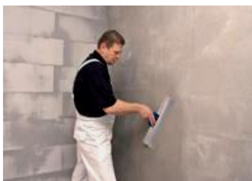
nanášanie kovovým hladidlom
