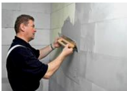
nanášanie kovovým hladidlom
